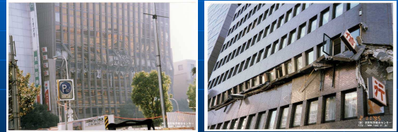
途中階部分の座屈
